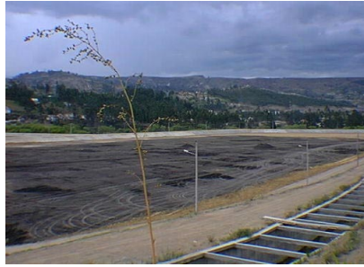
Vista de Laguna Facultativa 1 una vez terminados los trabajos de conformación de fondo - Abril de 1998
