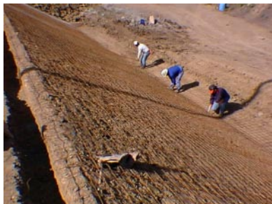
Colocación de Estructura de Hierro para Edificación de Taludes de Lagunas - Julio de 1997
