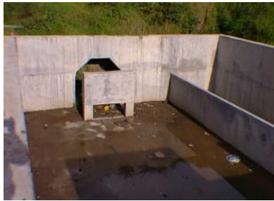
Edificación de Cajón de Llegada – Pantalla de Disipación de Energía y Estructura de By-pass - Junio del 1997
