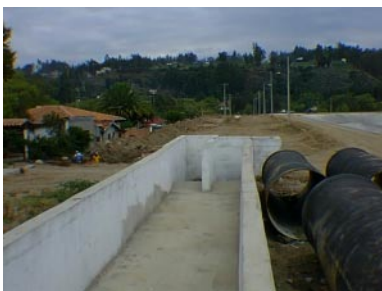
Edificación de Estructura de División de Caudales hacia Líneas de tratamiento 1 y 2 - Octubre de 1997
