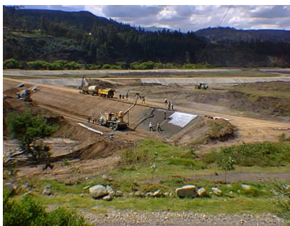
Edificación de Taludes de Laguna Aerada 1 – Abril de 1997
