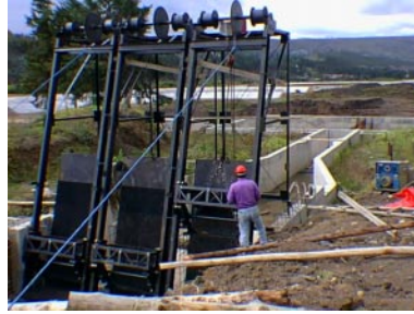
Implantación de Cribas Mecánicas Autolimpiantes – Abril de 1997
