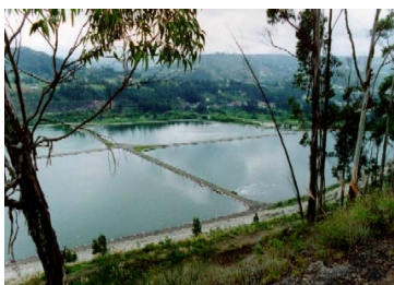
FOTOGRAFIA N° 3.6: Lagunas de Maduración
