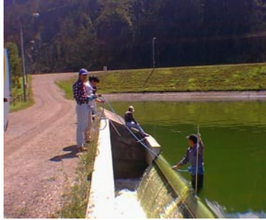
Calibración de Sensores en Vertederos de Estructuras de Interconexión y Desfogue de Agua Residual Tratada – Noviembre, Diciembre de 1999
