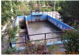
FOTOGRAFIA N° 3.1: Cajón de Llegada-by-pass- compuerta de admisión
