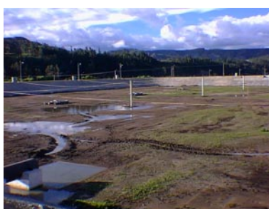
Vista de Laguna Aerada 1 una vez edificadas Estructuras para Soporte de Equipos de Aereación - Abril de 1998
