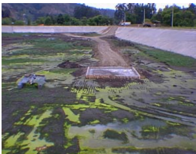
Edificación de Estructuras de Fondo para evitar socavación por acción de Aereadores - Febrero de 1999
