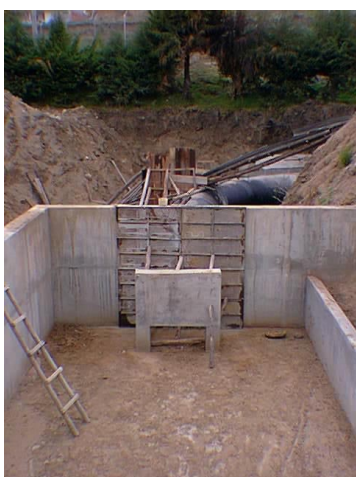
Implantación-Edificación de Emisario Final - Octubre de 1997
