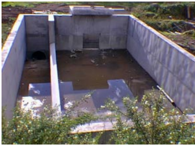
Edificación de Cajón de Llegada y Estructura de By-pass - Junio de 1997
