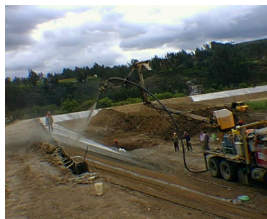
Fundición de Taludes de Laguna Aerada 1 con Hormigón Lanzado – Abril de 1997
