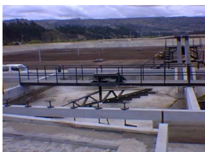
Desarenadores Cuadrados de Flujo Horizontal – Etapa de Evaluación – Agosto de 1998
