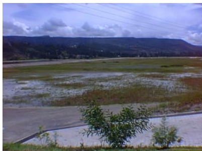
Vista de Laguna Facultativa 1 previo a reconformado de fondo para reintroducción de agua residual - Abril de 1999
