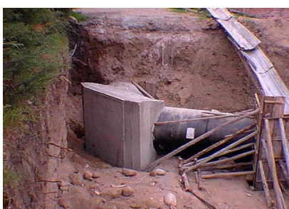
Empotramiento de Emisario Final en PTAR - Octubre de 1997
