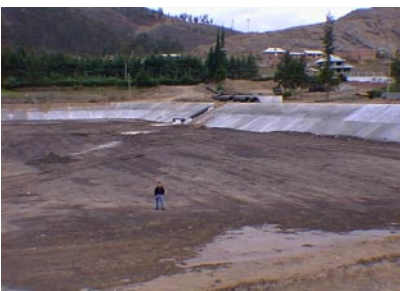
Laguna Aerada 1 una vez concluida la Fundición de Taludes - Octubre de 1997
