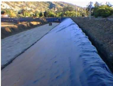
Edificación de Dique de Laguna Aerada 2 - Impermeabilización de Taludes - Julio del 1997
