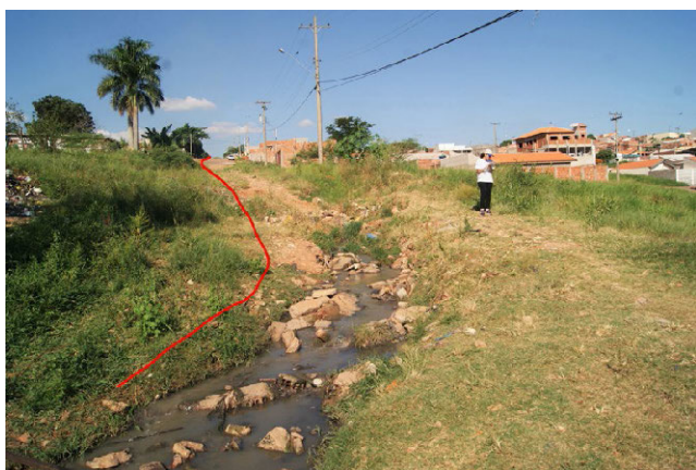
Figura 9. Aspectos da zona sul, com destaque para arruamento no sentido do declive (linha vermelha); destaque também para as características do solo (aspecto arenoso), ausência de cobertura vegetal (gramíneas esparsas) e escoamento superficial do esgoto.
