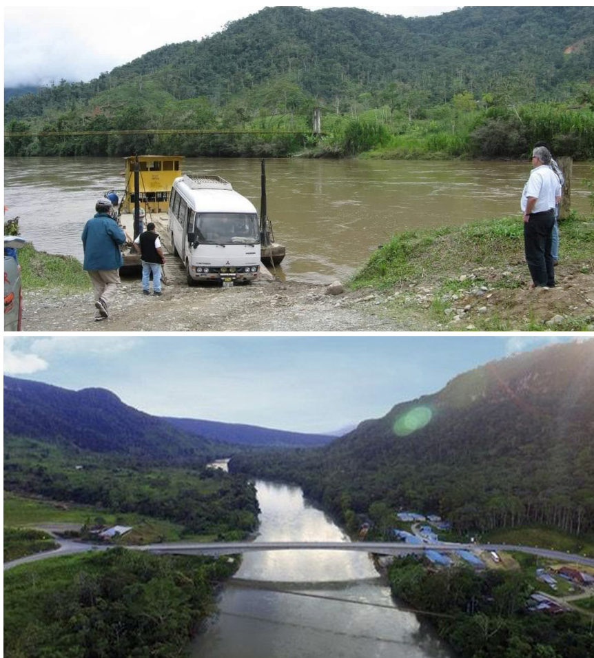
Figura 3. Fotografías históricas de la gabarra en el río Zamora, 2013; y el puente construido sobre el mismo río, 2019 Nota. Registro personal de morador, 2023 y Repositorio del gobierno local, 2023.
