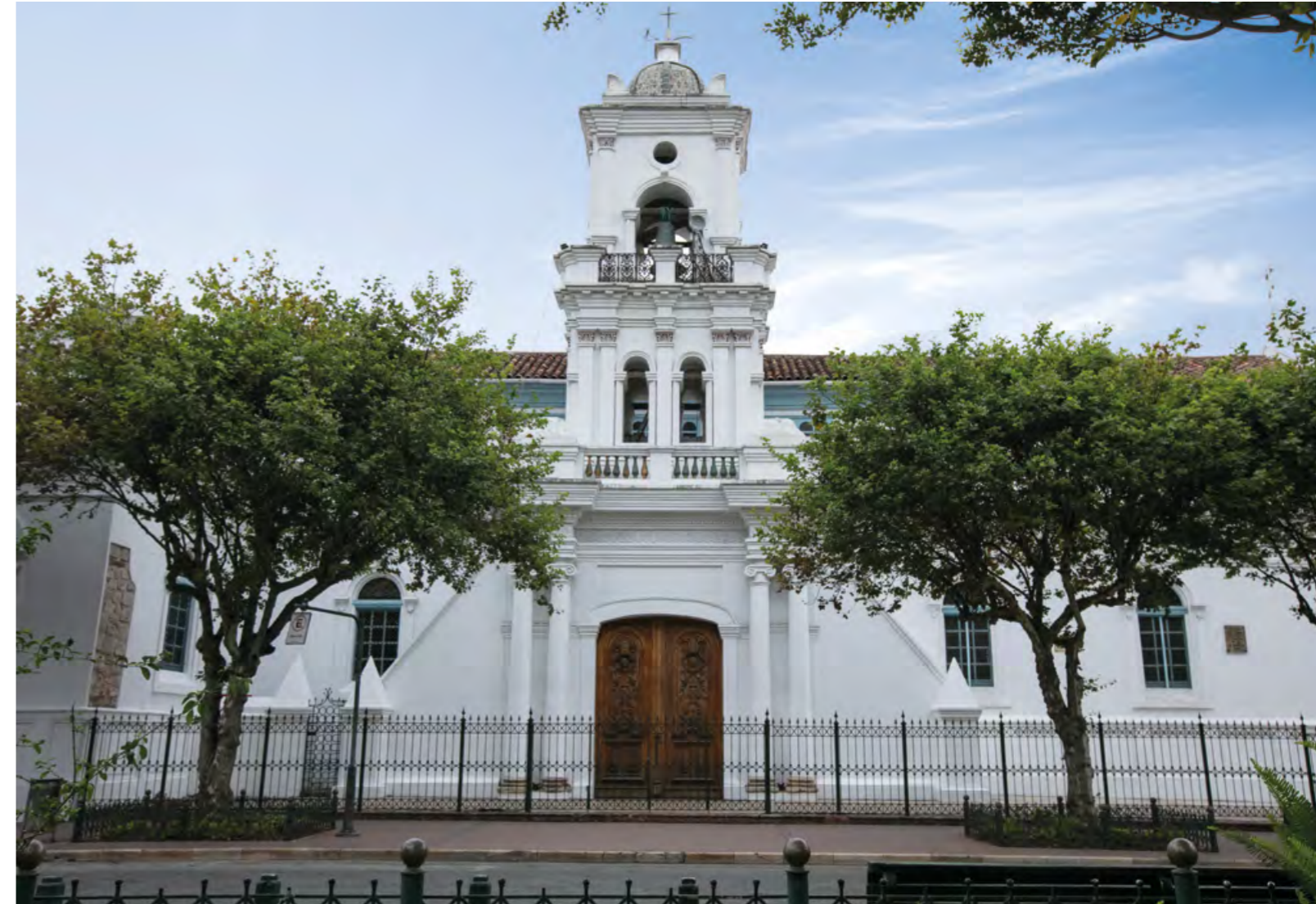
Fachada de la antigua Catedral de Cuenca, 2016. Foto: Cornelio Malo
