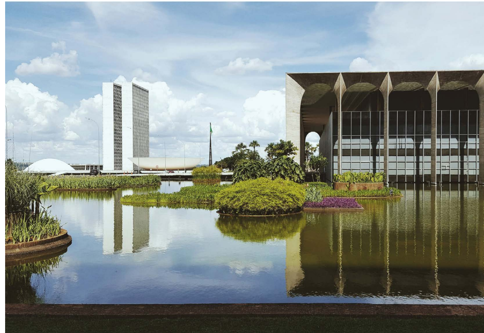
El Palacio Itamaraty en Brasilia, sede del Ministerio de Relaciones Exteriores de Brasil, la obra maestra del arquitecto Oscar Niemeyer, 1970. Foto: Ana Carolina Abad, 2018
